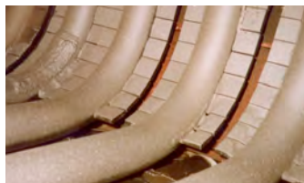
Tubi di caldai trattati con filo per spruzzatura ad arco
